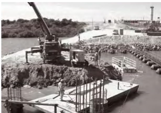
Metsä-Botnia aloitti selluloosatehtaan rakennustyöt Uruguayn puolella Fray Bentosissa. Kuva: Metsä-Botnia.
