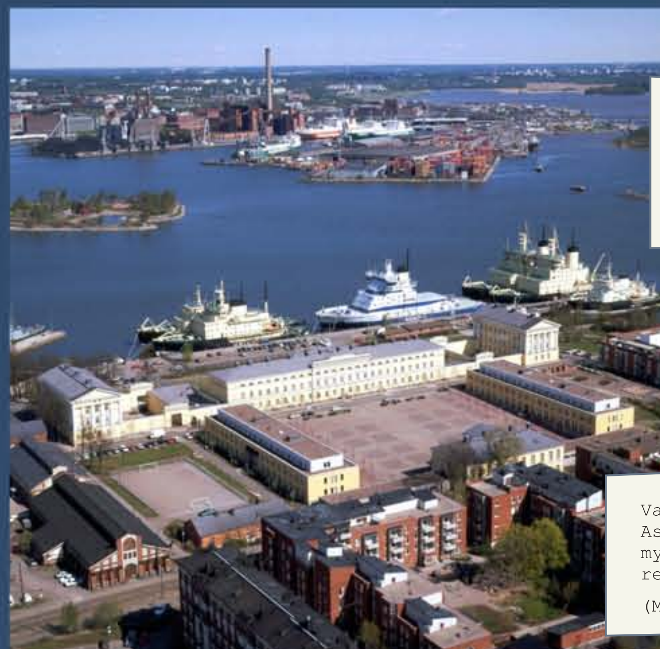
Merikasarmin rakennus Katajanokalla Helsingissä
